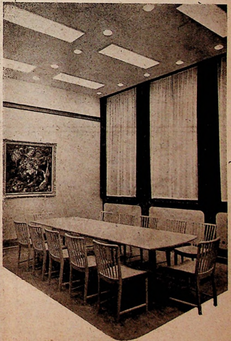
Voorbeeld van vruchtbare samenwerking tussen architect en installateur: een vergaderzaaltje met „TL” S-installatie, waarbij de buislampen en de „Stabilux”-lampen afzonderlijk in het plafond werden opgenomen.
